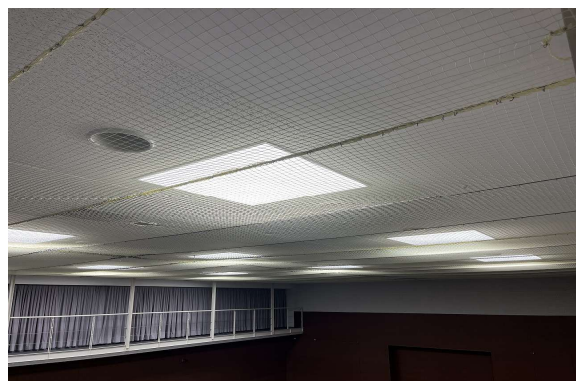
防護ネット柵取付完了状況 (第一リハーサル室)
